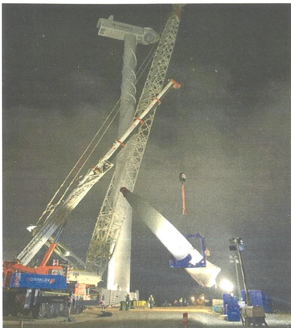
Sur Koudia Al Baida, Somalev a mobilisé des ressources humaines et des équipements ayant nécessité plus de 100 millions de DH d'investissement. Quant au projet de Dakhla, le montage des turbines servira à produire l'électricité qui alimentera la station de dessalement de la région (Ph. privée)
