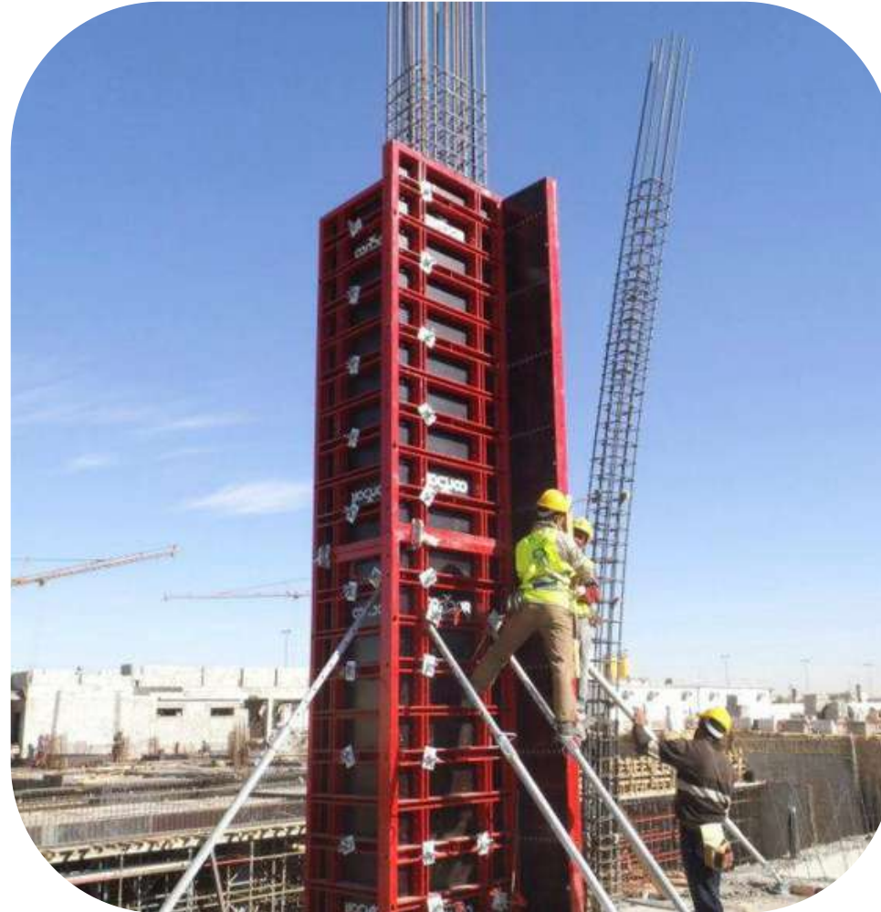
Coffrage de poteaux
