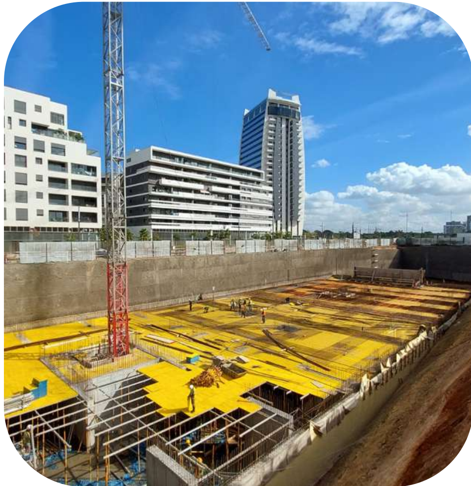
Coffrage de dalles
