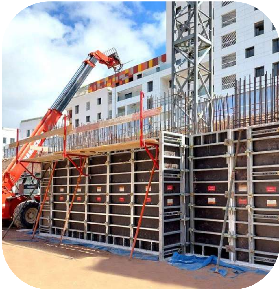
Coffrage de voiles
